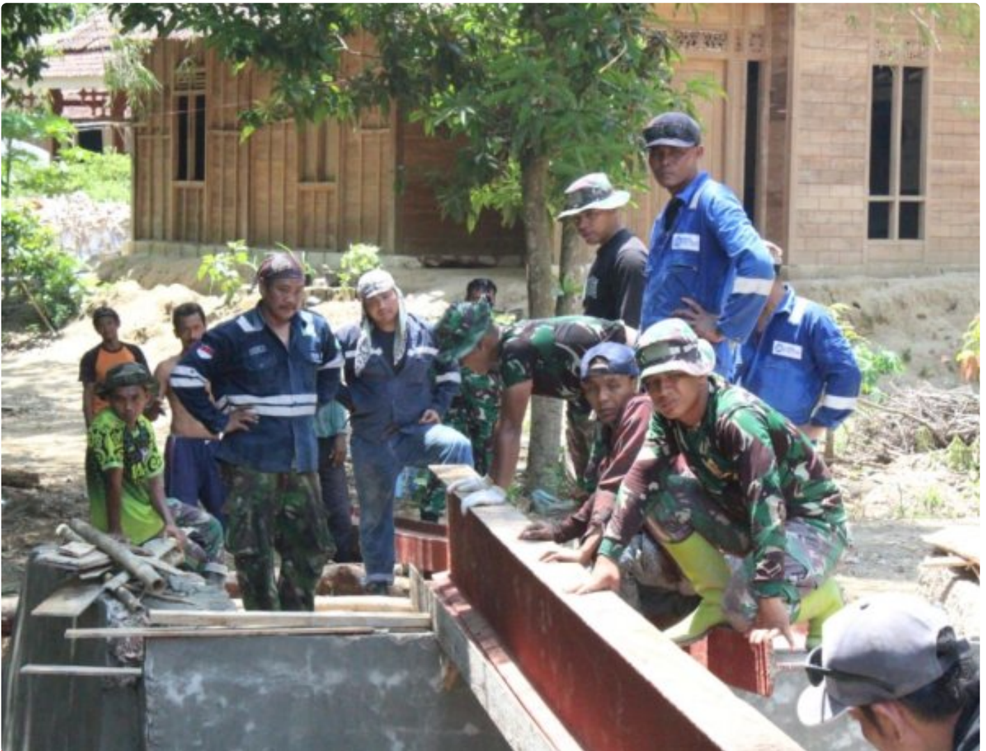
Foto: Anggota Satgas TMMMD Reg 122 Kodim 0721/Blora Melaksanakan Pekerjaan Pembangunan Jembatan.
