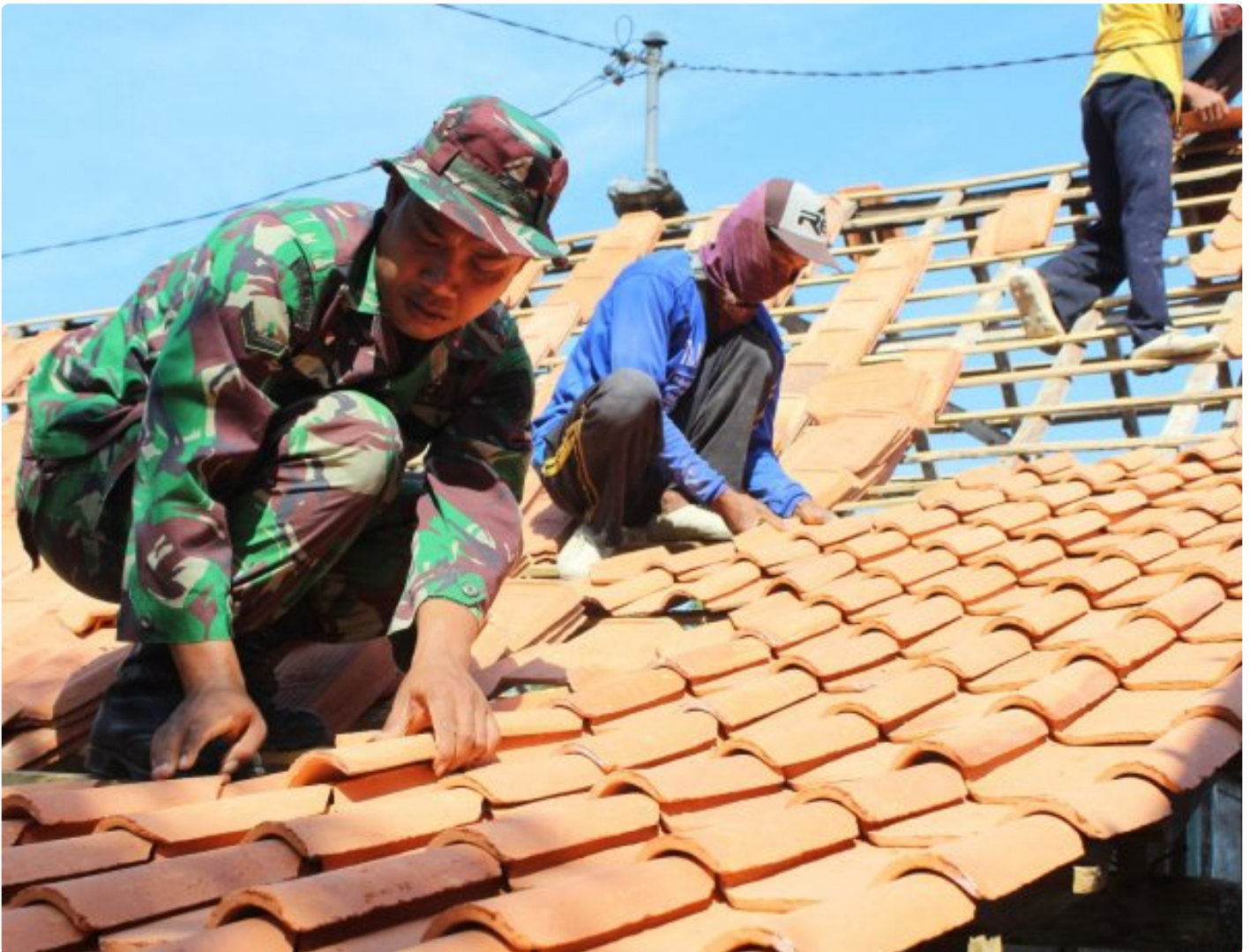
Foto : Satgas TMMD Reg 122 Kodim 0721/Blora Pengerjaan Rumah Tidak Layah Huni.
